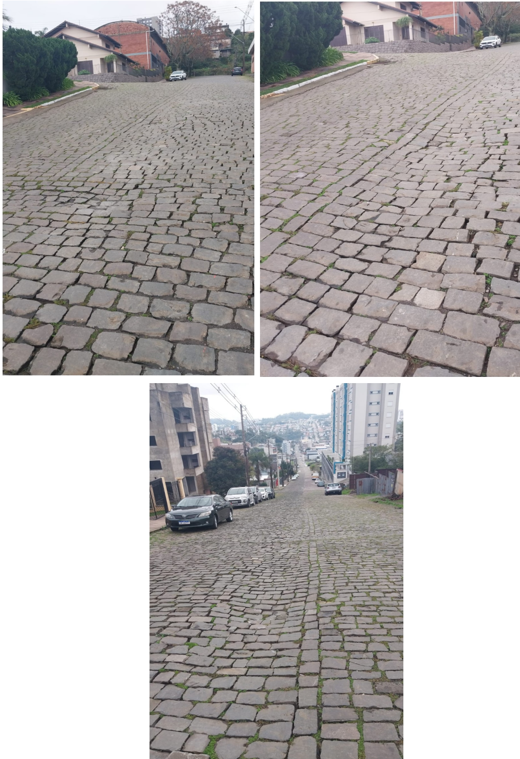
Rua Amáble Campagmolo Sonza, 105 (afundamento da pista de rolamento).
