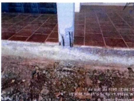
Fotografia 9 – Corrosão do pilar do hall de entrada
