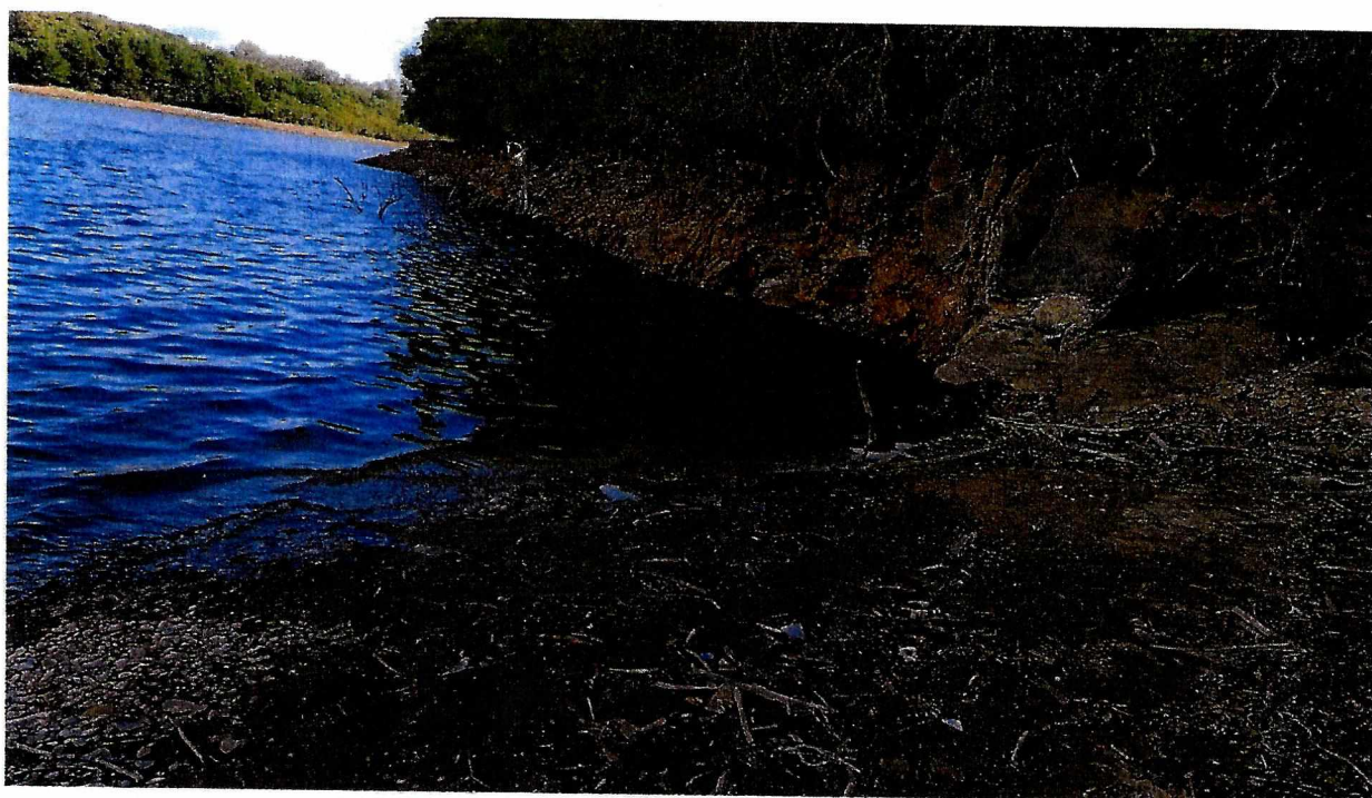
Foto 09: Ponto 04 área do barramento
