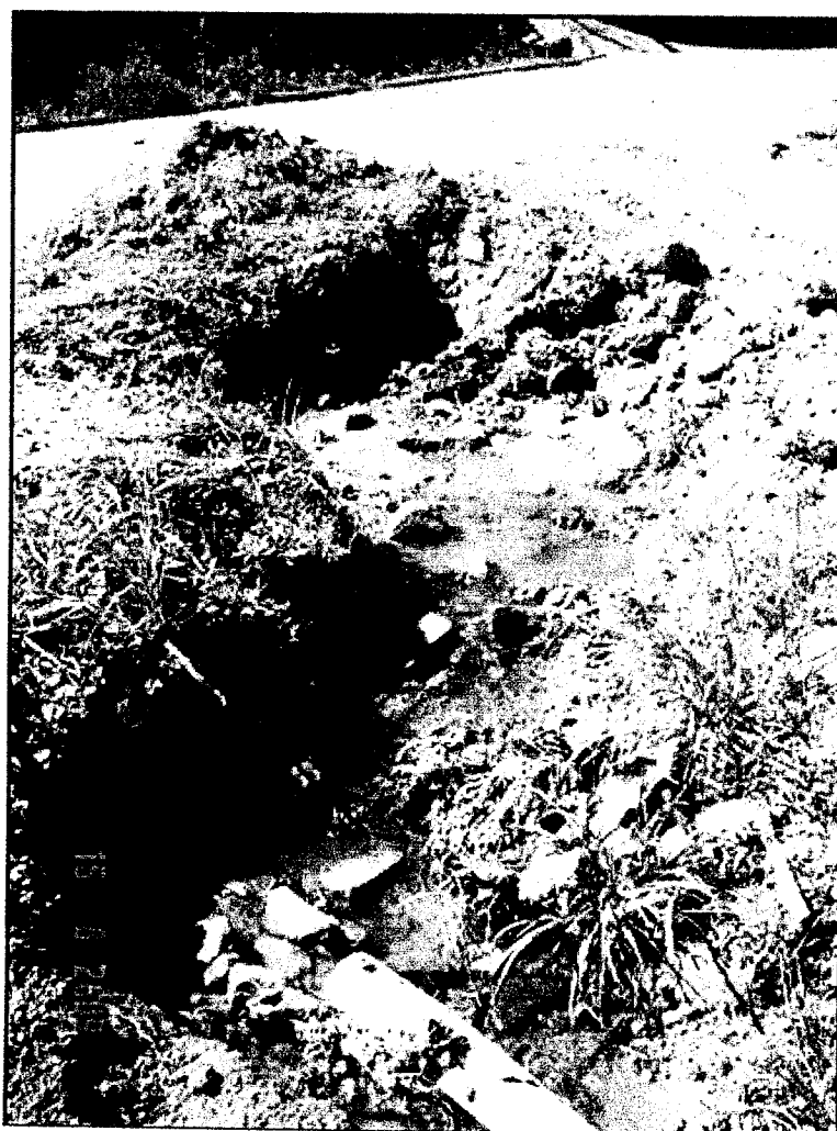
Local onde a drenagem pluvial adentra na propriedade de Ademir Lorenzini.
