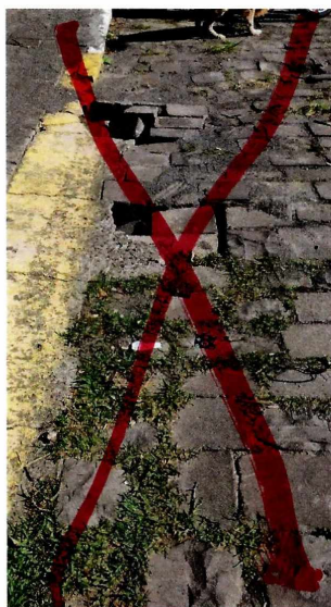
RUA AMÉLIO BELUSSO FERRARI. Abaixo do nº 137, em frente ao portão do posto de saúde.
